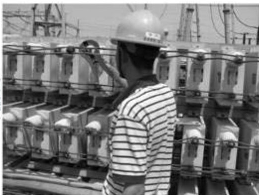
图 4 仪器现场测量实例
